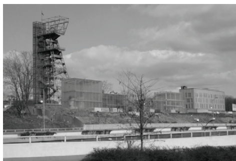
Fot.6. Szklane wieże, doświetlające podziemne ekspozycje w budowanym Muzeum Śląskim w Katowicach (fot. E. Gonda-Soroczyńska)
