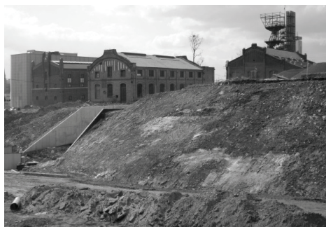
Fot.8. Pokopalniane obiekty byłej Kopalni „Katowice” poddane rewitalizacji, obecnie obiekty Muzeum Śląskiego w Katowicach w budowie (fot. E. Gonda-Soroczyńska)
