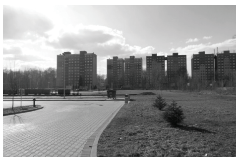
Fot.4. Zabudowa mieszkaniowa wielorodzinna dla górników byłej kopalni „Michał” w Siemianowicach Śląskich (fot. E. Gonda-Soroczyńska)
