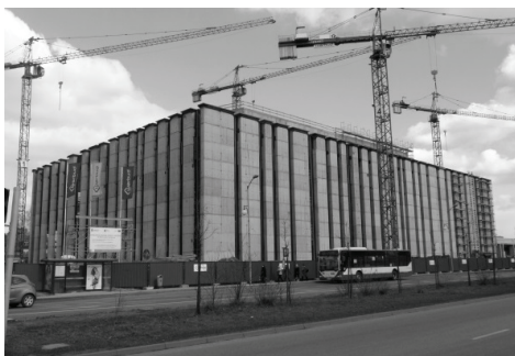
Fot.7. W trakcie realizacji Siedziba Narodowej Orkiestry Symfonicznej Polskiego Radia w Katowicach, w bezpośrednim sąsiedztwie Muzeum Śląskiego w Katowicach (fot. E. Gonda-Soroczyńska)
