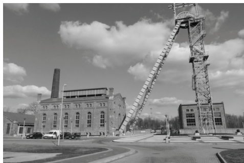
Fot.1. Siemianowickie Centrum Kultury, Park Tradycji w Siemianowicach Śląskich z wieżą wyciągową (fot. E. Gonda-Soroczyńska)
