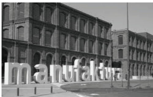
Fot.17. Centrum handlowo-usługowo-kulturalno-rozrywkowe „Manufaktura” w Łodzi, zrewitalizowane obiekty podfabryczne, http://www.mmlodz.pl [dostęp: 30.06.2013].
